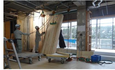
図 4 CLT 耐震壁の設置施工状況
