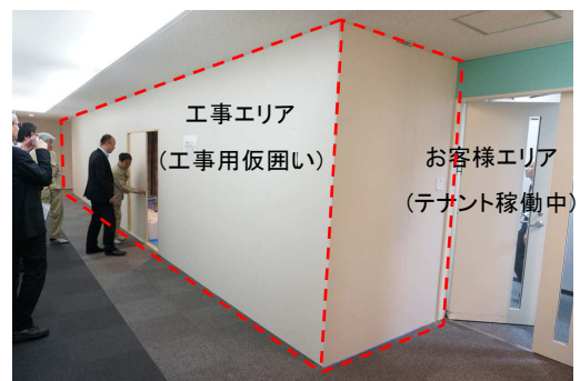
(a) 工事エリア仮囲い状況
