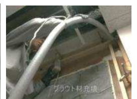
(d) 現地型枠のみとした グラウト充填
