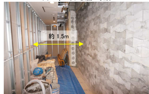
(b) 作業エリア内部
