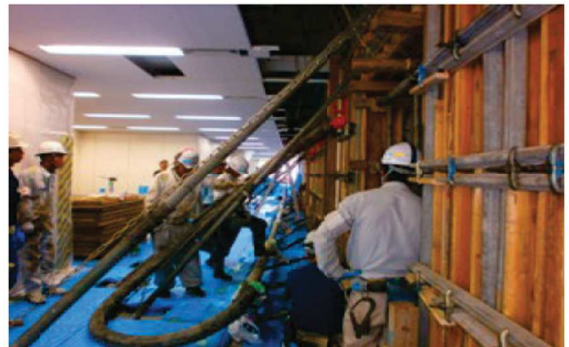
(a) コンクリート打設工事状況
