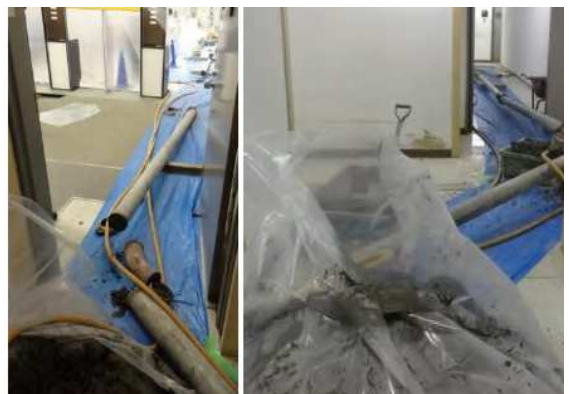
(b) 圧送管設置状況
