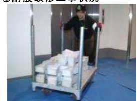
(b) 人力による搬入状況
