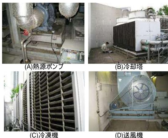
写真5 設備機器の振動測定状況
