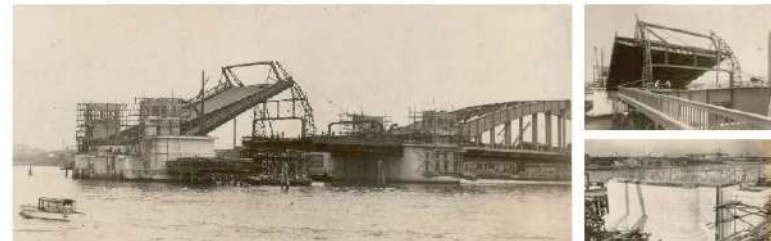
(工事中の勝鬨橋)
