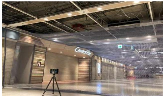
写真1 地下街天井改修工事中における3次元測量
