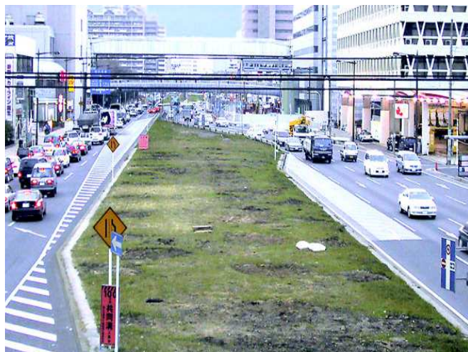
幅の広い中央分離帯を挟んで片側2車線の車道でした
