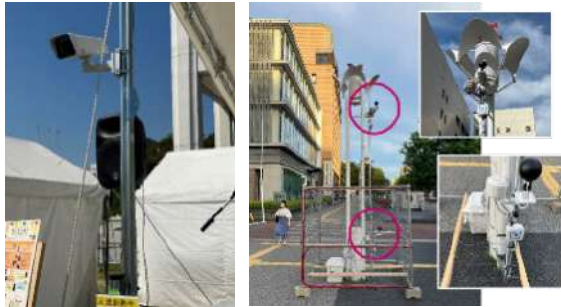
IoT機器の設置の様子 （左：AIカメラ、右：環境センサ）
