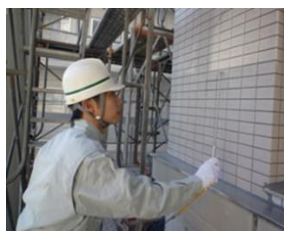
写真1【打診検査状況】
