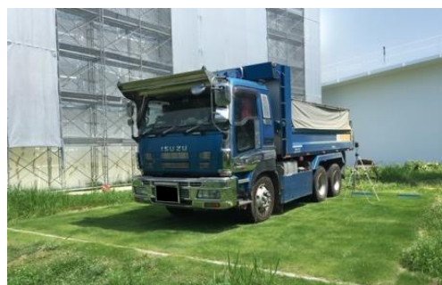
図-13 20t ダンプ荷重試験状況
