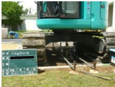
図-6 平板載荷試験状況
