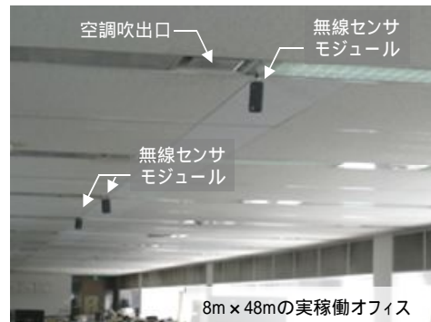
写真3 実稼働オフィスの実証試験
