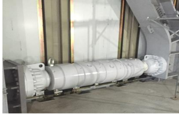
写真1 高減衰オイルダンパー (工事中の建物における取付状況)
