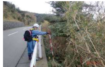
道路より下にある斜面の点検状況
