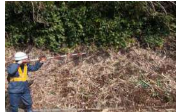
道路より上にある斜面の点検状況
