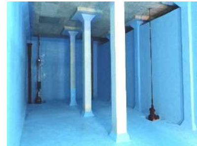
写真-11 上水用配水池の施工例
