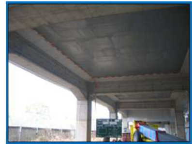
写真-10 高架橋の施工例
