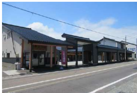
写真6 再建が進む本町通りの雁木
