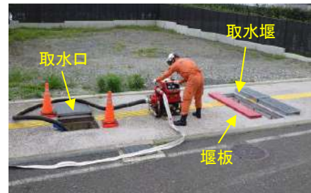
写真2 奴奈川用水路の取水施設（堰板を取水堰内部のスリットに沿って落として水を貯め取水口から放水する）
