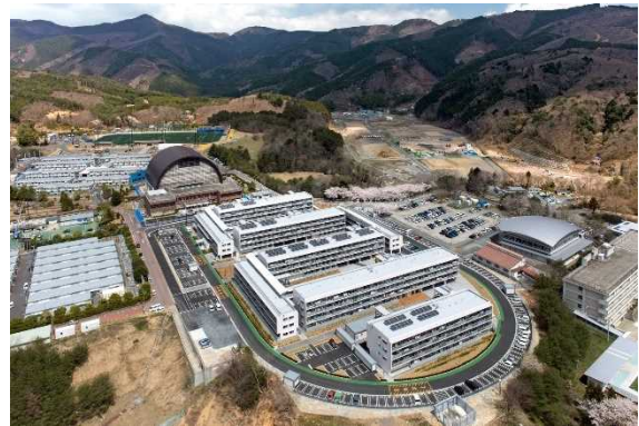
図 10 高台の公園用地を用途転換し、災害公営住宅を建設 （撮影：ブルーアワーズ/沖 裕之）
