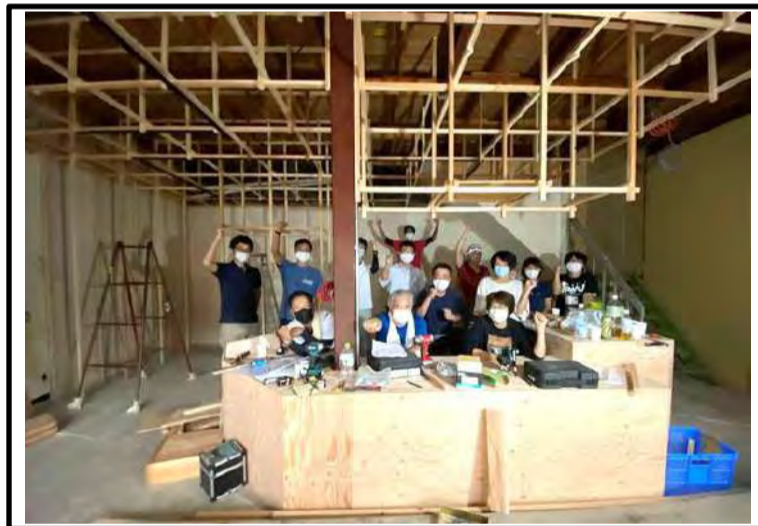
空き家の利活用の作業を実施しました。後片付けからDIYの作業まで幅広く作業を実施しています。ヒダスケ!の参加者がその後もシェアスペースとして利用されています。
