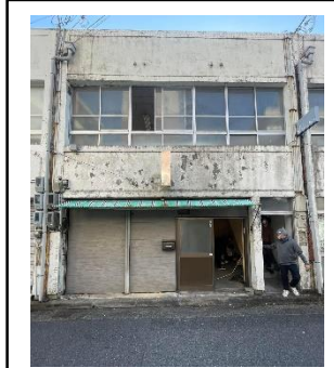
モレル橋脚下 テナント 第2回リノベーションスクール対象物件 ※事業化に向け協議中
