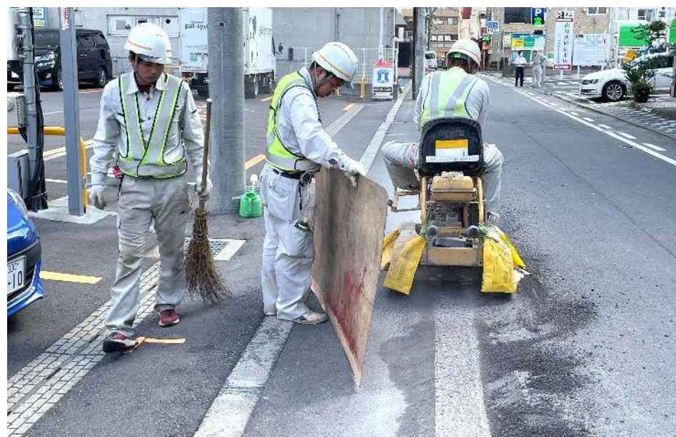
白線引き換え施工
