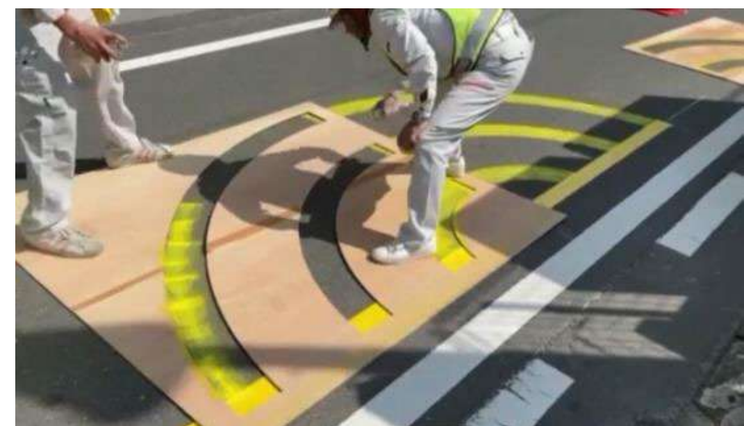
路面サイン施工
