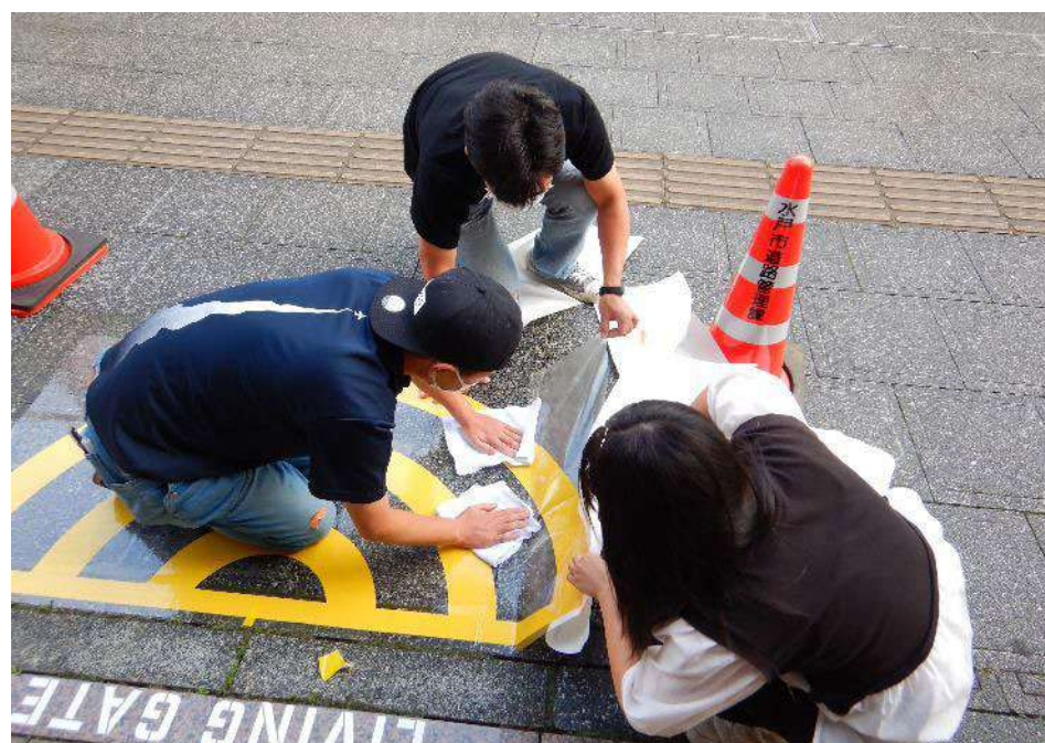
路面サイン施工（市民WS）
