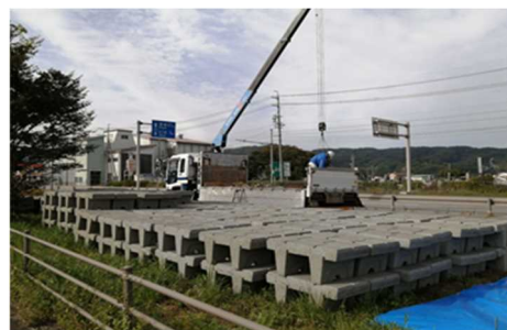
写真3 仮置きヤードの活用状況
