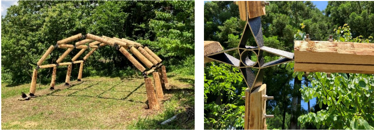
図 16 モックアップ架構の竣工状況(左:全景, 右:接合部詳細)
