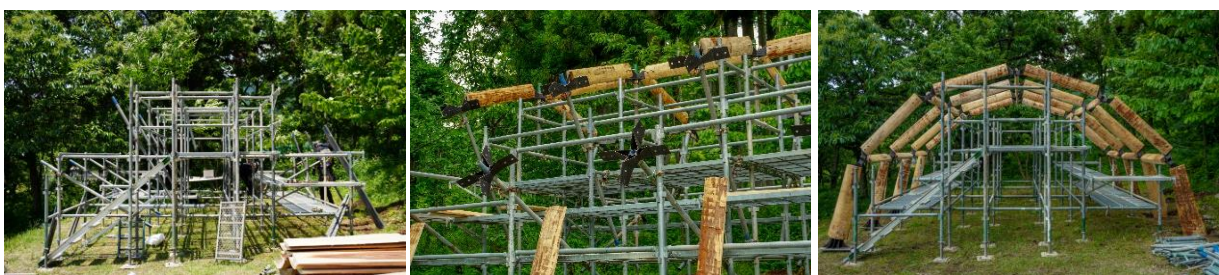
図 15 モックアップ架構の施工状況(左:仮設足場組立て, 中:接合部位置決め, 右:全体仮組状況)
