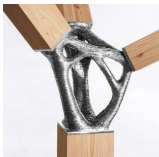
図 5 金属 3D プリンターによる自由形状接合部
