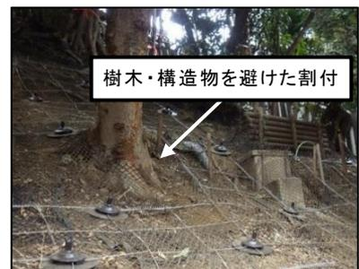
写真3 完成後の斜面部(ユニットネット工法)
